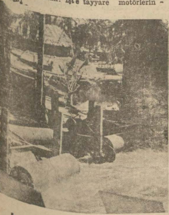
5 — Bir tekneyi parçalayan büyük dalgaları vücade etmek için, 100 kadem murabba bir kazan içinde şu gördüğümüz üstüvane şeklindeki makineler işler.
